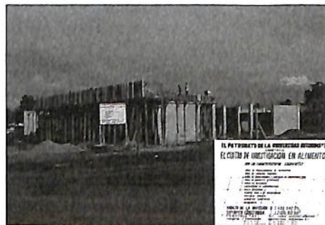
Figura 1 Inicio de construcción del Centro de Investigación en Alimentos por el Patronato Universitario.
