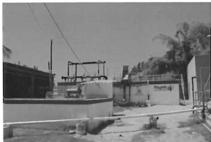
Figura 17. Planta de Tratamiento Sayulita Fuente: fotografía tomada en Sayulita, Bahía de Banderas
