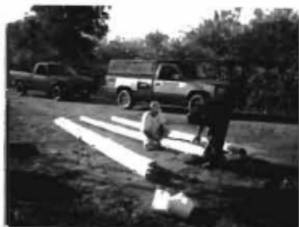
Tubería utilizada para el drenaje
