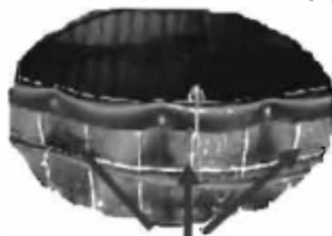
Figura 19. Remaches para fijar geomembrana a estructura
