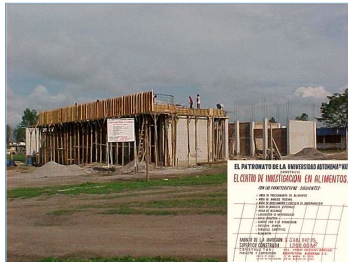
Figura 1. Etapa de construcción del Centro de Investigación en Alimentos
