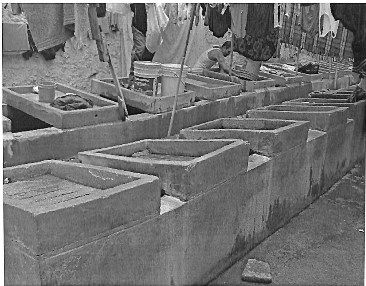
Lavaderos de ropa para internos varones del Centro De Rehabilitación Social "Venustiano Carranza"
