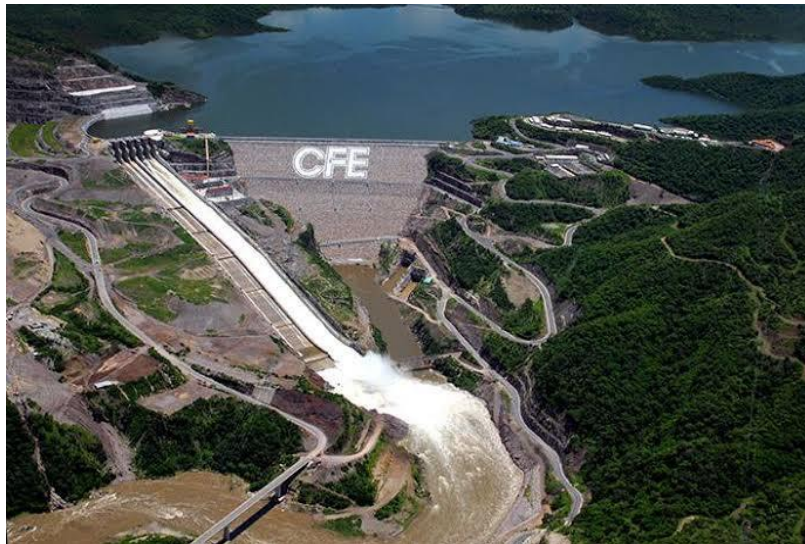
Ilustración No. 2 Presa hidroeléctrica El Cajón 2003-2007
