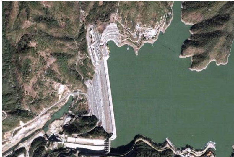
Ilustración No. 1 Presas hidroeléctricas Aguamilpa 1989-1993
