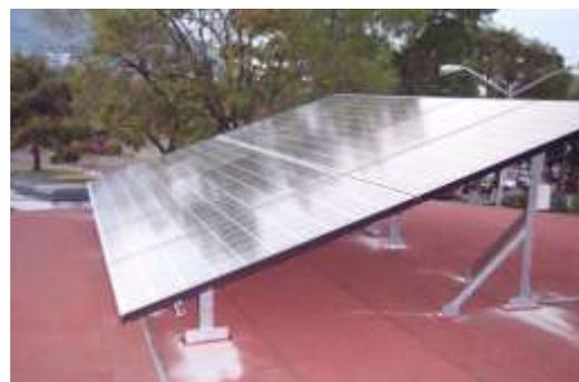
Figura 3. Sistema fotovoltaico de 2.4 kW interconectado con la red eléctrica instalado el edificio administrativo del área de ciencias básicas e ingenierías de la UAN.
